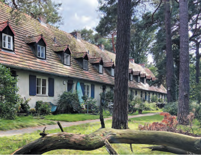
„Steine und Holz sind nicht böse“: Häuserreihe der Siedlung mit ge- pflegter Bepflan- zung und altem Baumbestand
