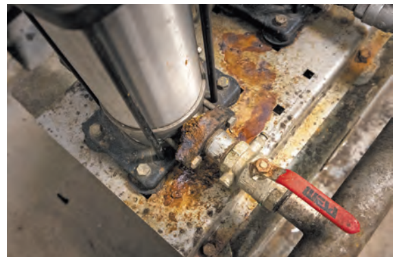
In erbärmlichem Zustand: Wasserdruckanlage im Keller des Hauses Franz-Künstler-Straße 2
