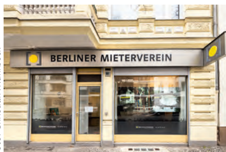
Beratungszentrum Wilmsdorfer Straße in der Zillestraße 81
