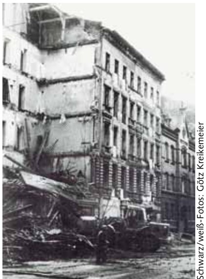
Abriss und Neubau in der Putbusser Straße 22, 23, 24
