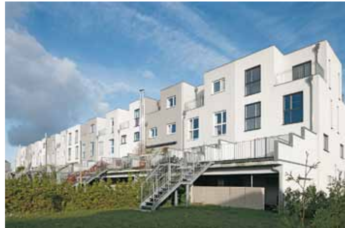
Der Neubau befriedigt zurzeit hauptsächlich die Nachfrage nach Eigentum und gehobenem Wohnstandard
