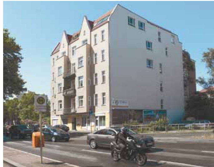
Viel Potenzial steckt im Rückbau breiter Straßen (Foto oben: Hohenstaufenstraße) ...
