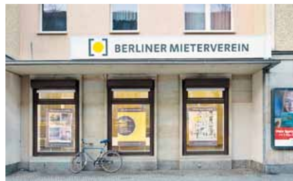
Beratungszentrum Frankfurter Allee in der Frankfurter Allee 85
