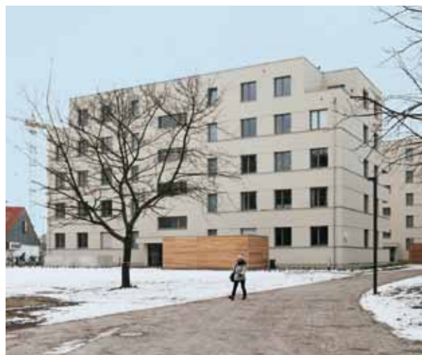
Genossenschaftsbaustellen in der Schwyzer Straße (links), am Groß-Berliner Damm (unten), in der Dresdener Straße (rechts)
