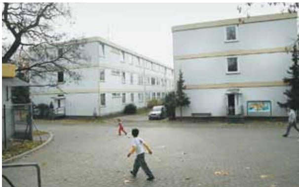
Erste Anlaufstelle für Asylanten in Berlin sind diese Container in der Spandauer Motardstraße
