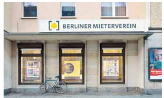
Beratungszentrum Frankfurter Allee in der Frankfurter Allee 85
