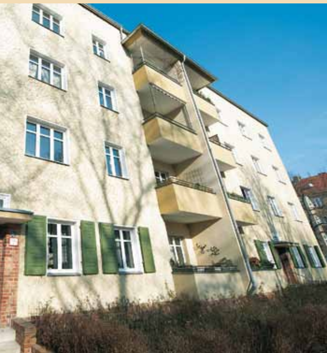
Die Wohnanlage steht unter Denkmalschutz – nach der Rückübertragung 1992 wurde sie modernisiert
